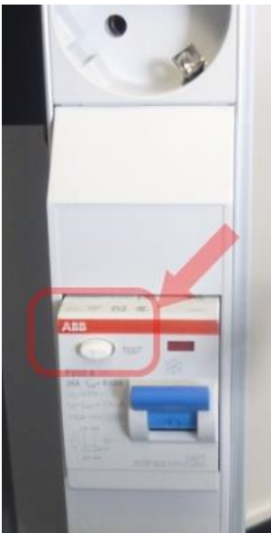
Abbildung 4: Prüftaste des Fehlerstromschutzschalters (RCD)
