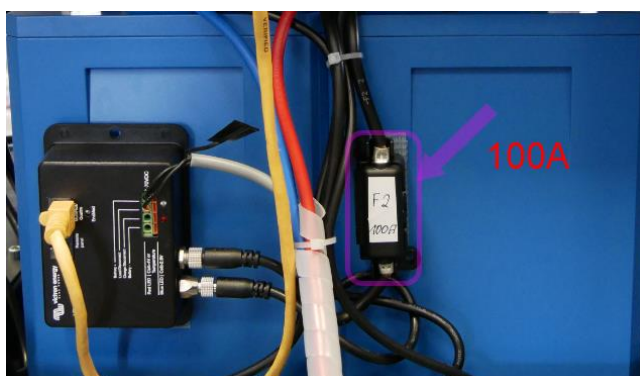
Abbildung 34: MAX BE 750/1200 Li-Ionen und MAX Plus 750/1200 Li-Ionen Sicherung an Batterien
